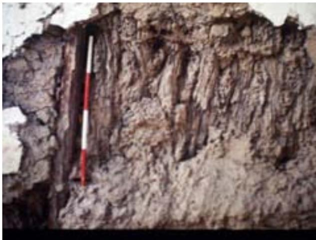
*Foto N° 35: sector de un rancho actual donde se aprecia la pared de chorizos de barro y parte del revoque con barro y bosta*
